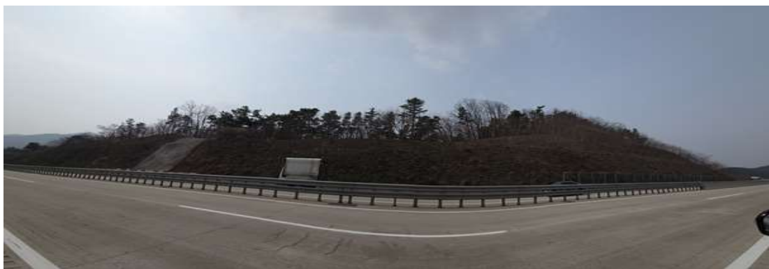
영천절토 12 (관리이정 16.844~17.264km / 3공구 STA.0+830~1+250)
